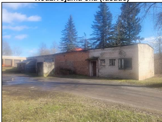
Nedzīvojamā ēka (fasāde)
