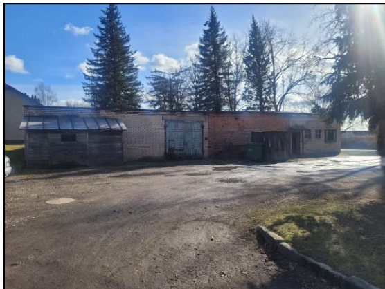
Nedzīvojamā ēka (fasāde)
