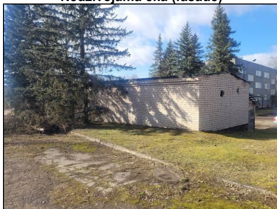
Nedzīvojamā ēka (fasāde)
