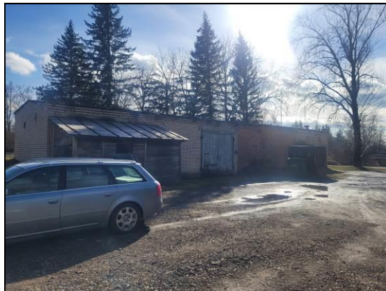
Nedzīvojamā ēka (fasāde)
