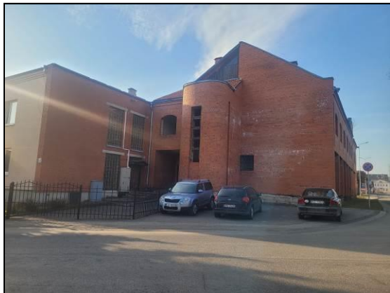
Administratīvā ēka (fasāde)
