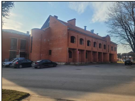
Administratīvā ēka (fasāde)
