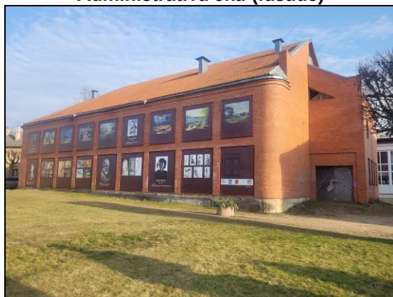
Administratīvā ēka (fasāde)
