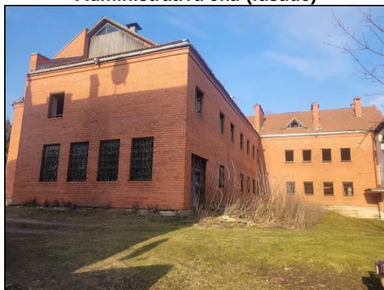
Administratīvā ēka (fasāde)
