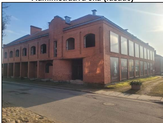
Administratīvā ēka (fasāde)
