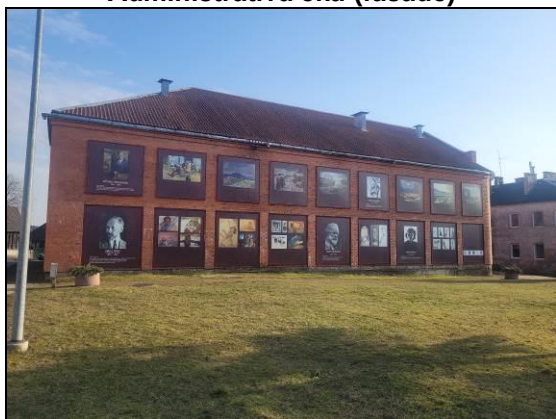
Administratīvā ēka (fasāde)
