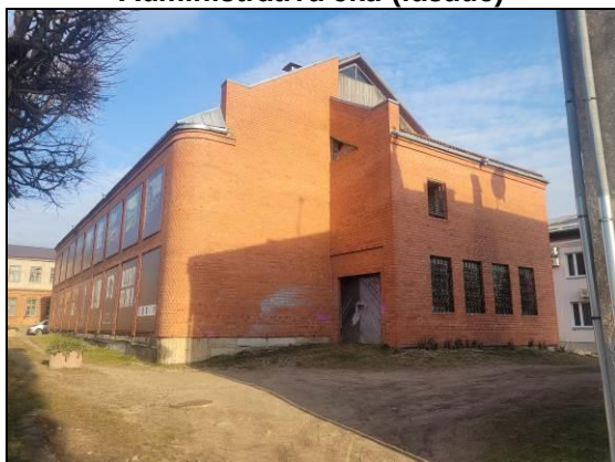
Administratīvā ēka (fasāde)
