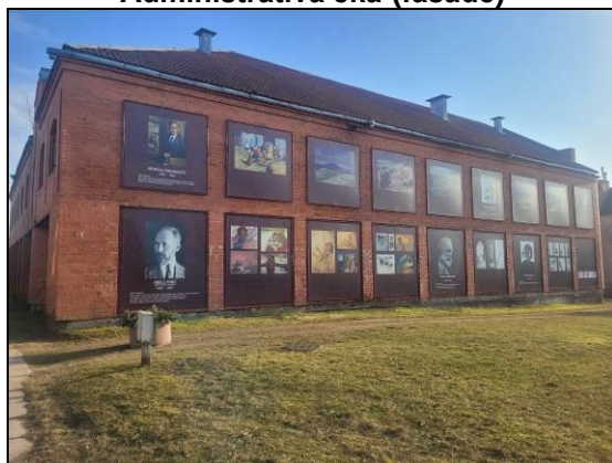
Administratīvā ēka (fasāde)
