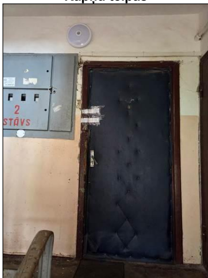
Kāpņu telpas (dzīvokļa ārdurvis)
